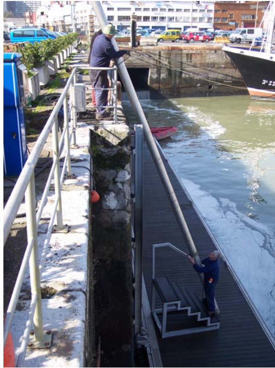
Figura 7: Apoyo del tubo externo en el pantalán.
