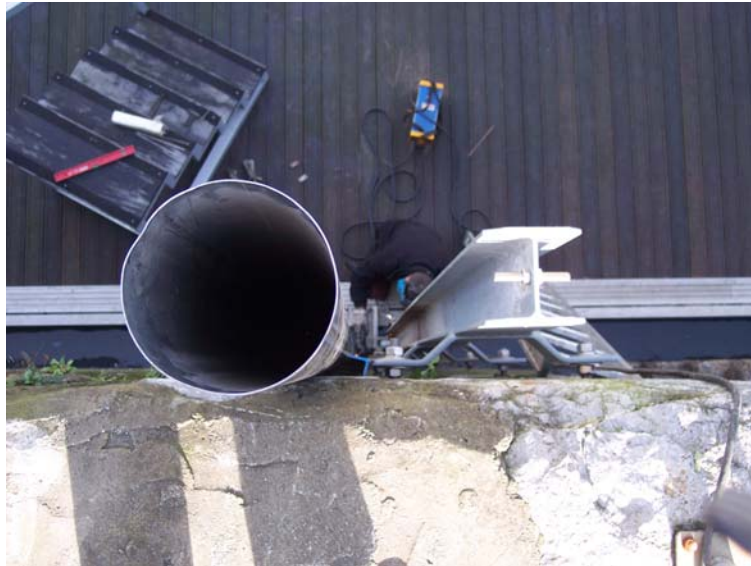
Figura 4: Tubo externo y guía del pantalán
