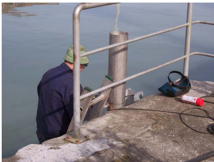
Figura 11: Recortando el tubo externo hasta la guía del pantalán
