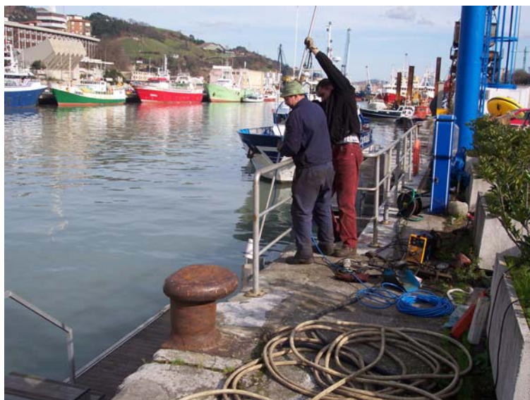
Figura 12: Introduciendo en sensor en el tubo externo
