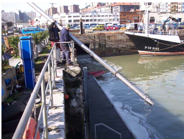
Figura 6: Colocación del tubo externo
