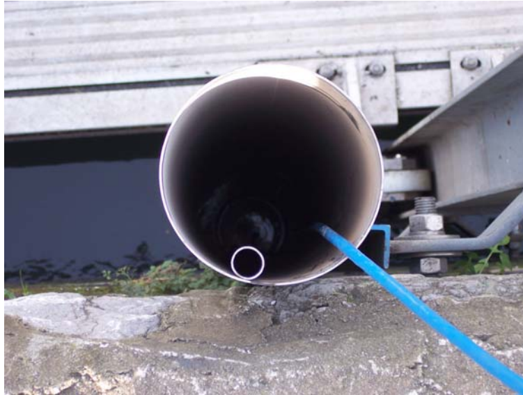
Figura 13: Vista cenital de los tubos colocados
