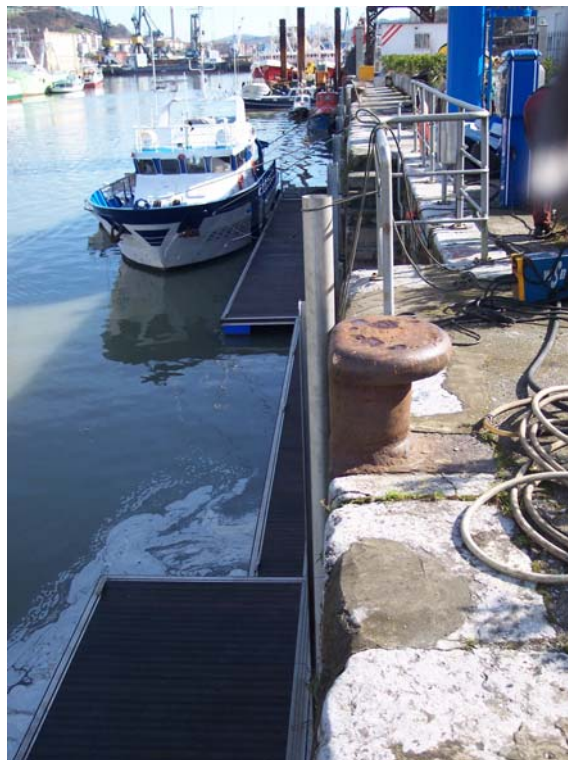
Figura 9: Detalle del tubo externo colocado
