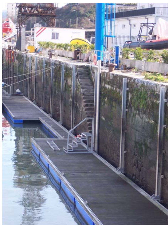
Figura 10: Vista general del tubo externo colocado
