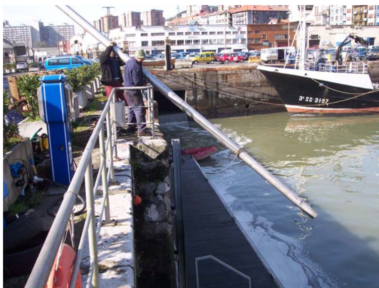
Figura 6: Colocación del tubo externo
