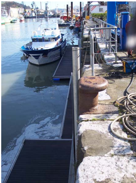
Figura 9: Detalle del tubo externo colocado
