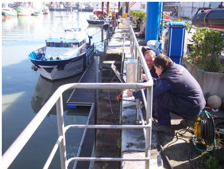
Figura 14: Caja de almacenamiento de la electrónica del sensor
